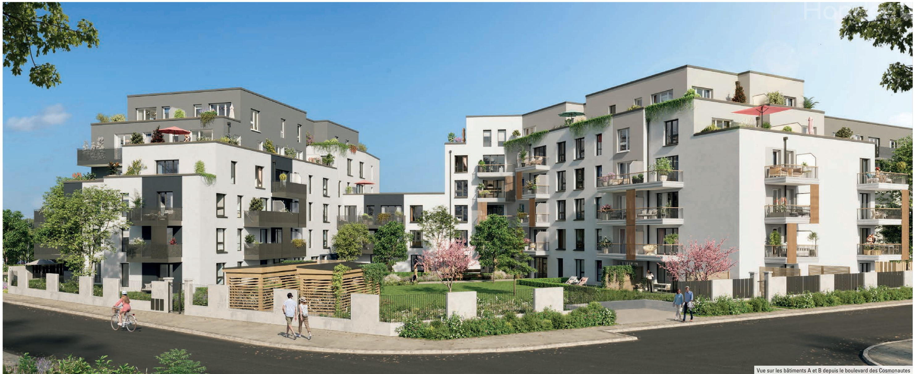
Vue sur les bâtiments A et B depuis le boulevard des Cosmonautes
