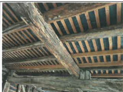
Photo n° PhTer001 Localisation : 2ème étage - Grenier 10 Ouvrage : Plafond - Charpente bois et ardoises Parasite : Présence d'indices d'infestation d'autres agents de dégradation biologique du bois Indices : altérations dans le bois (présence étendue)
